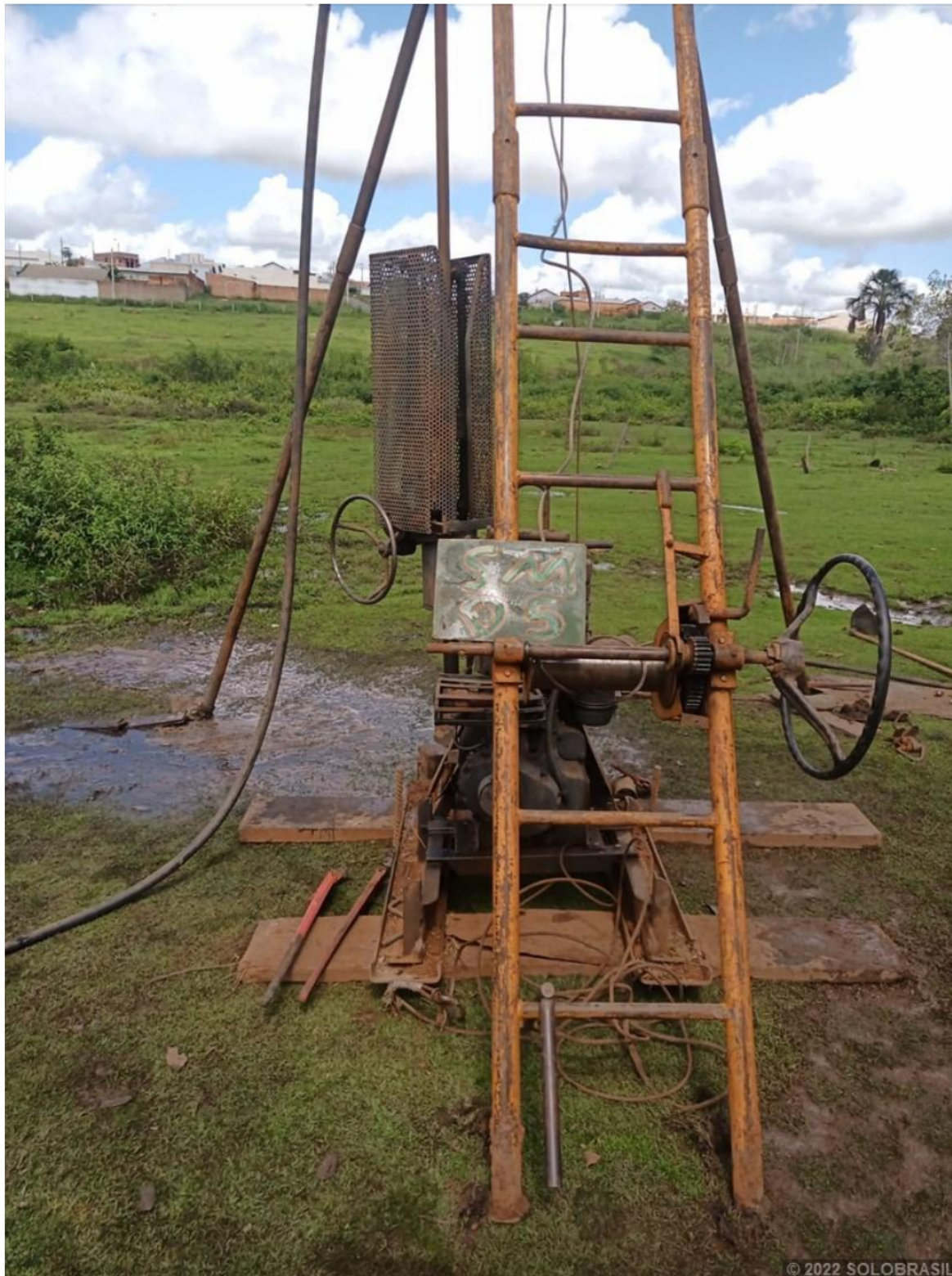
Montagem do equipamento - SM05
