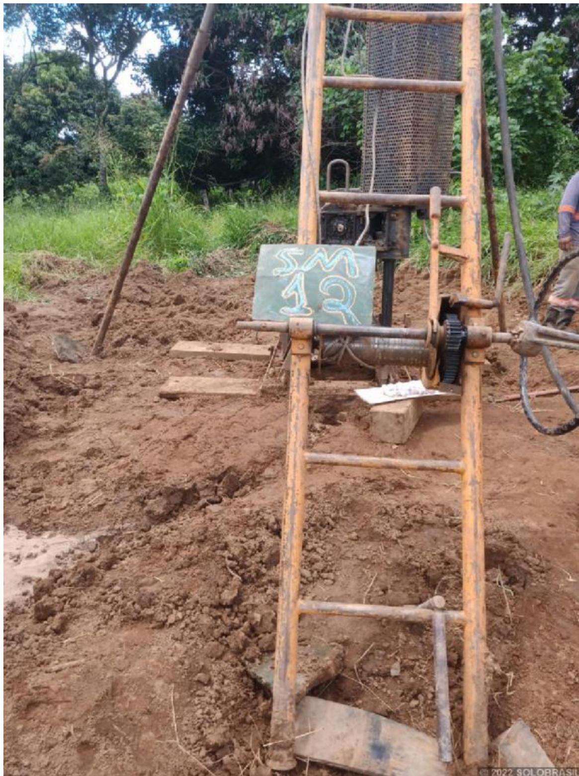
Montagem do equipamento - SM12
