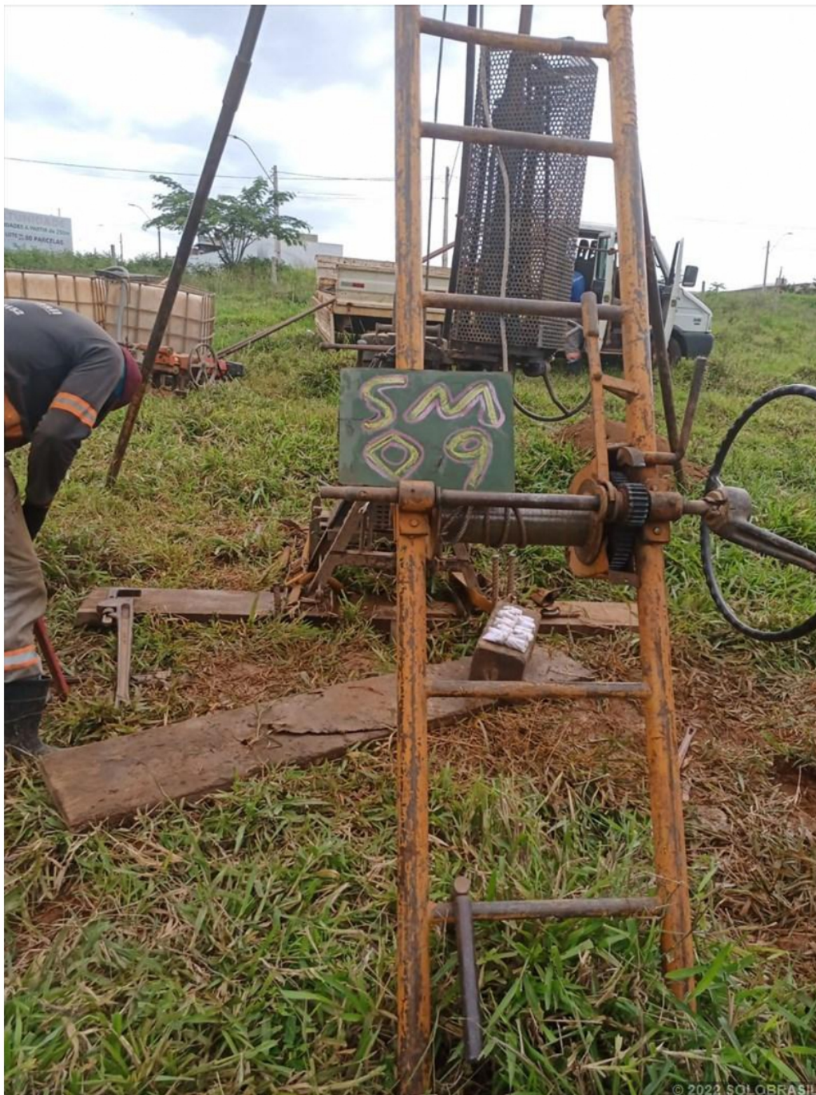
Montagem do equipamento - SM09
