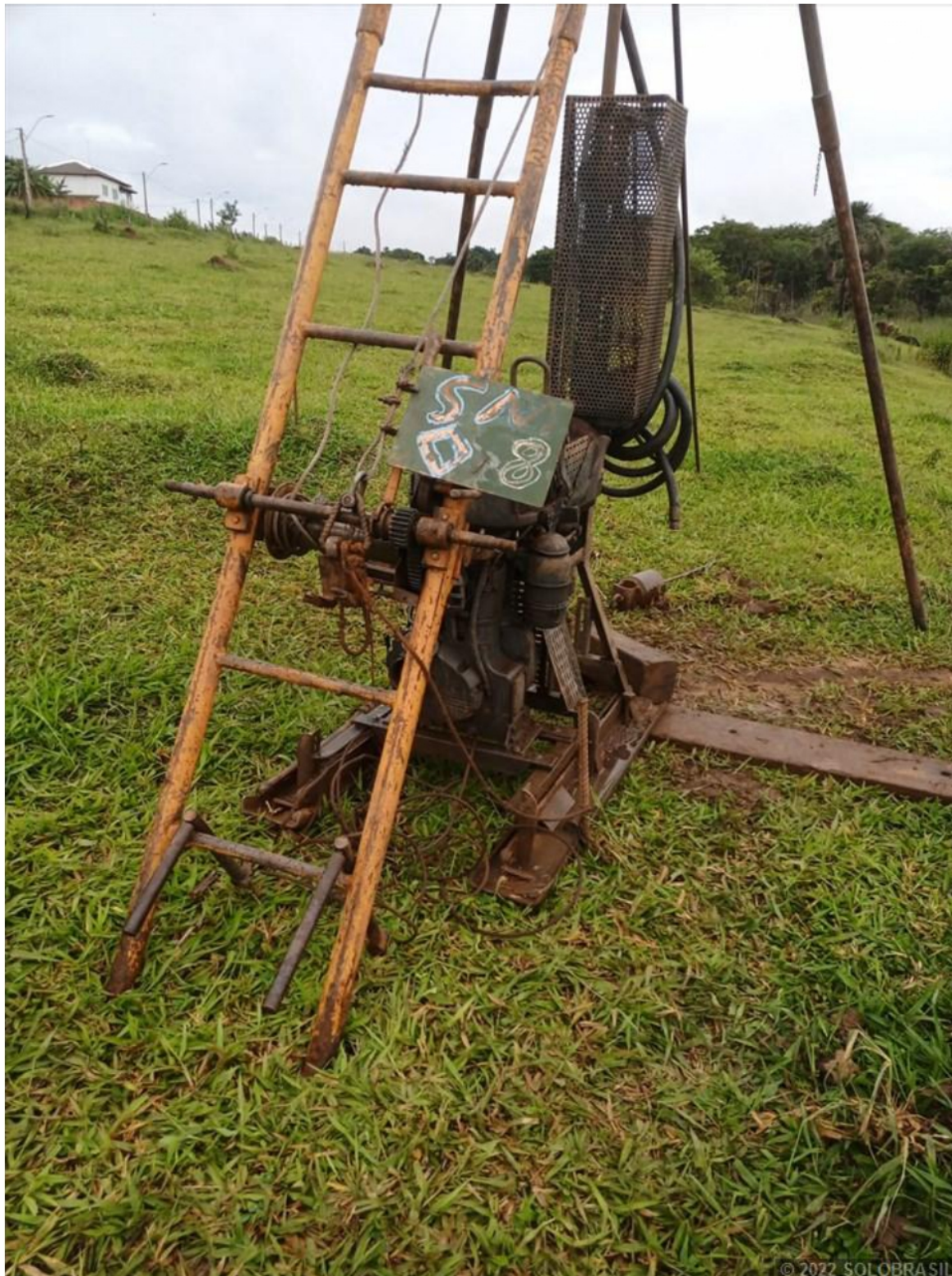
Montagem do equipamento - SM08
