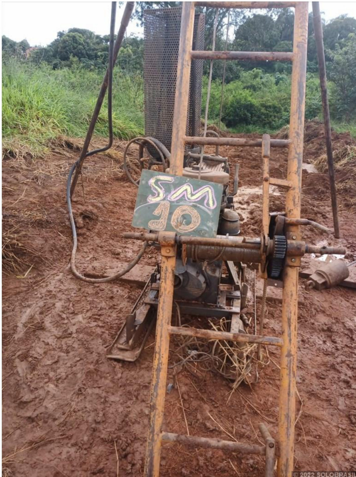
Montagem do equipamento - SM10
