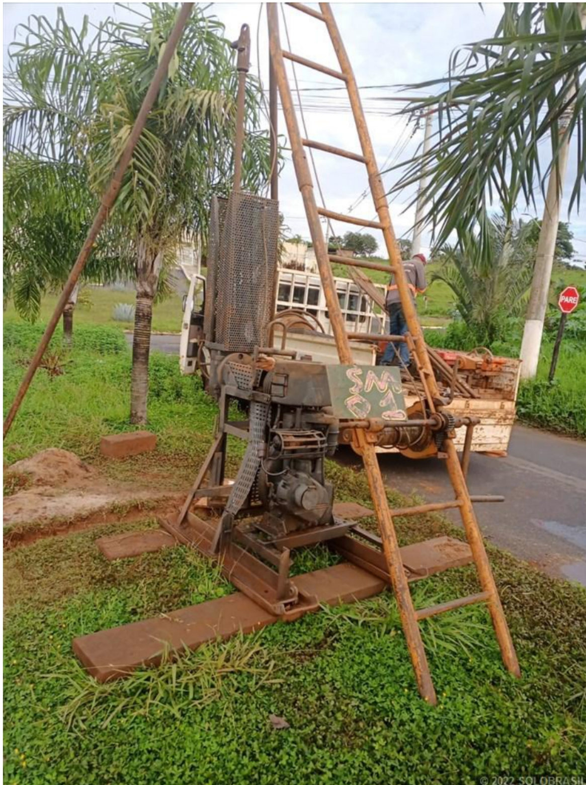
Montagem do equipamento - SM01
