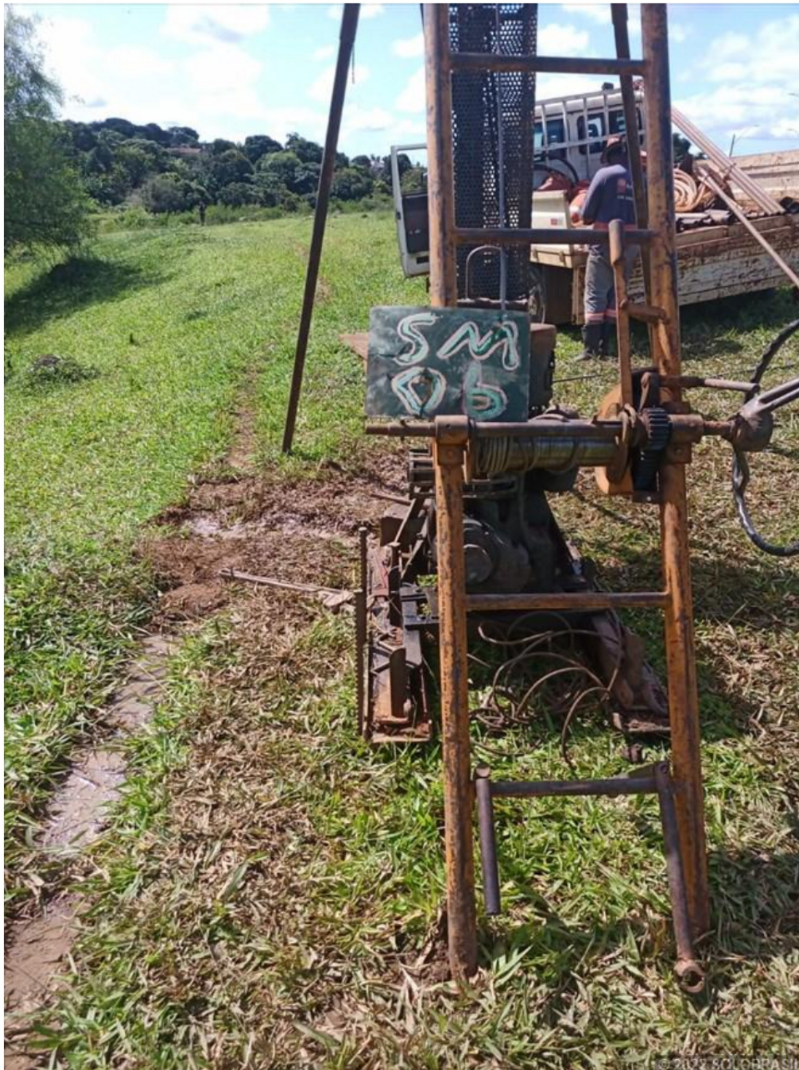
Montagem do equipamento - SM06
