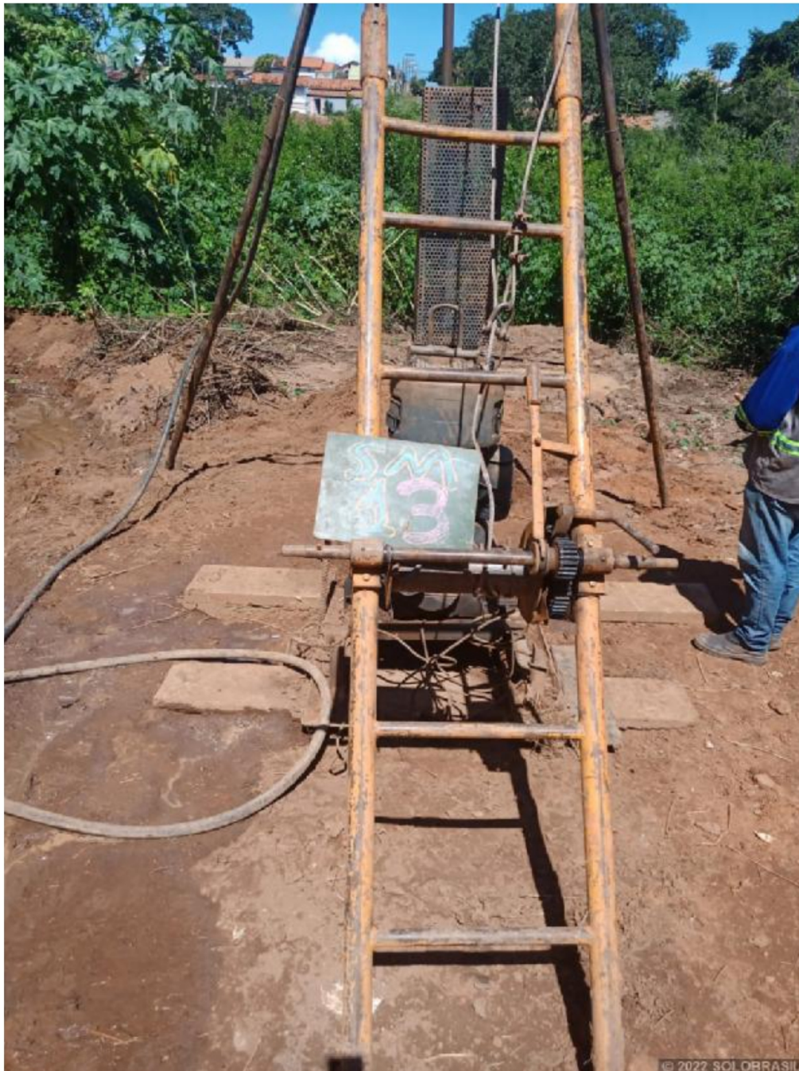
Montagem do equipamento - SM13
