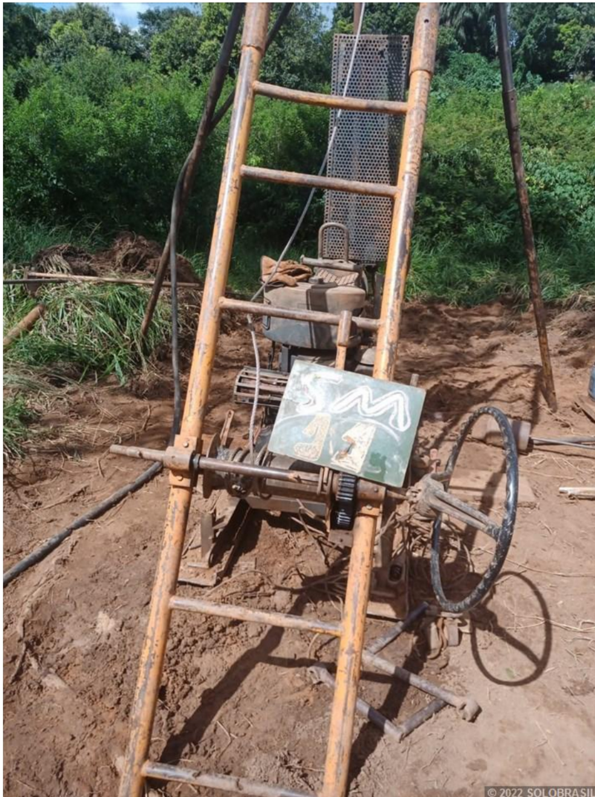
Montagem do equipamento - SM11
