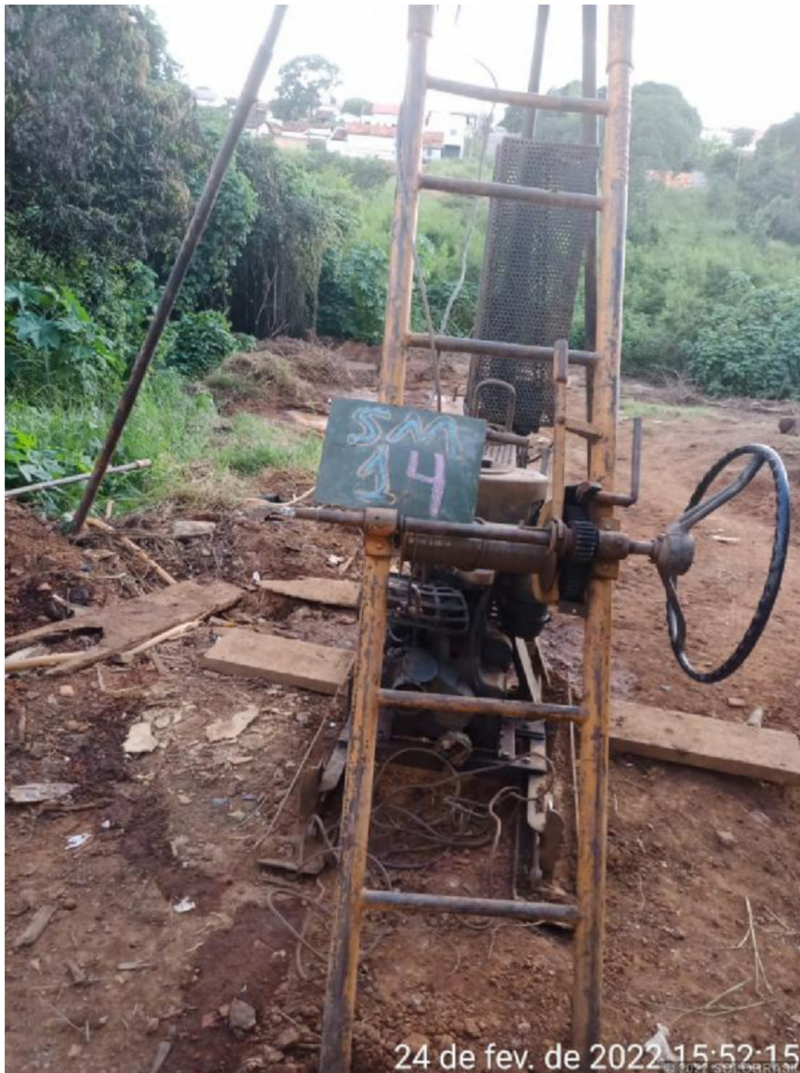
Montagem do equipamento - SM14
