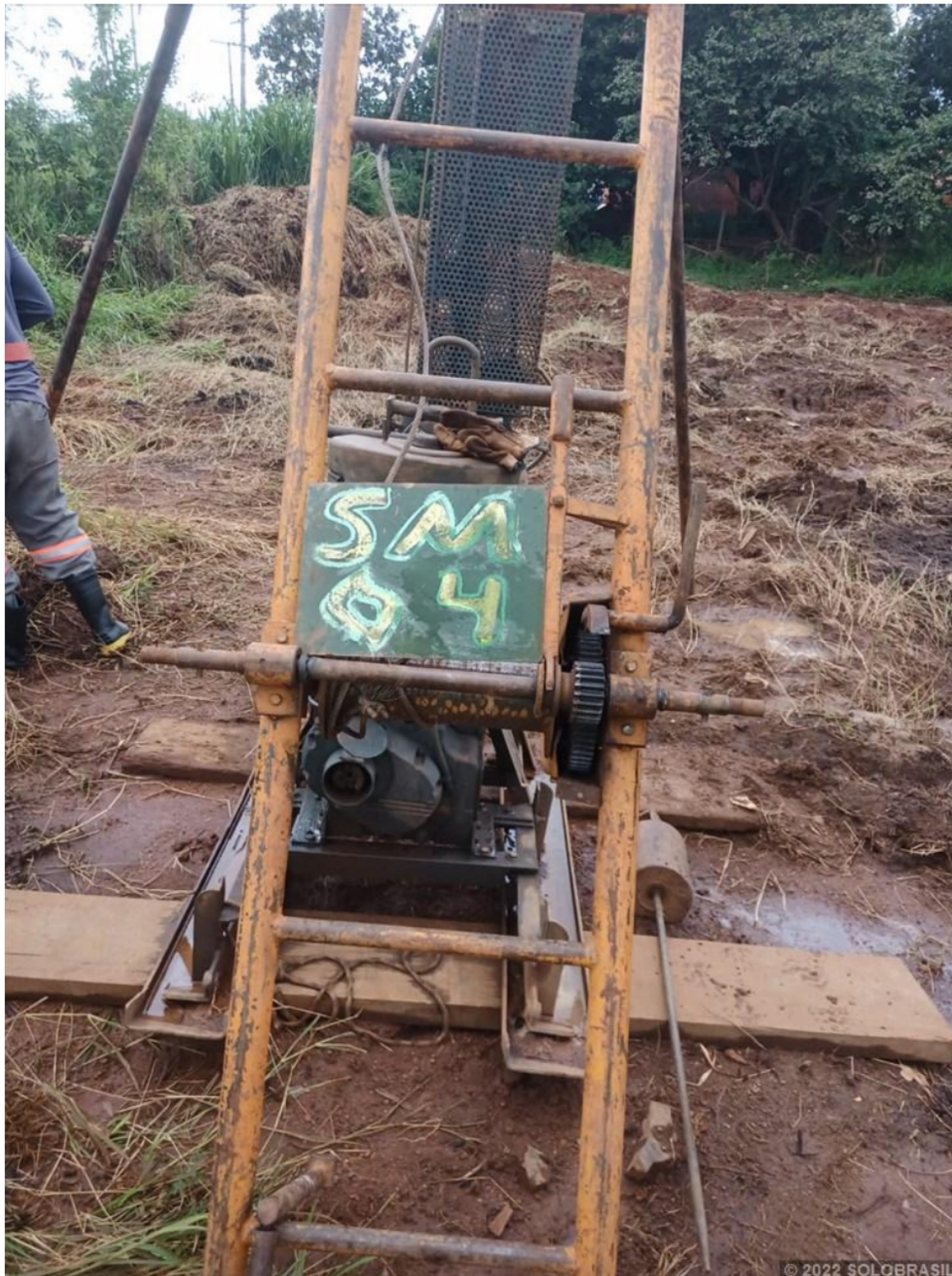
Montagem do equipamento - SM04
