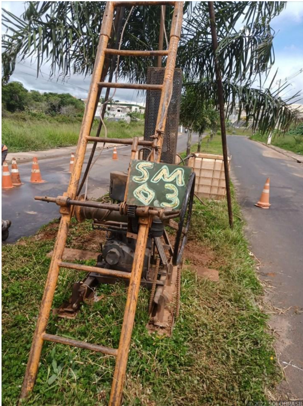
Montagem do equipamento - SM03
