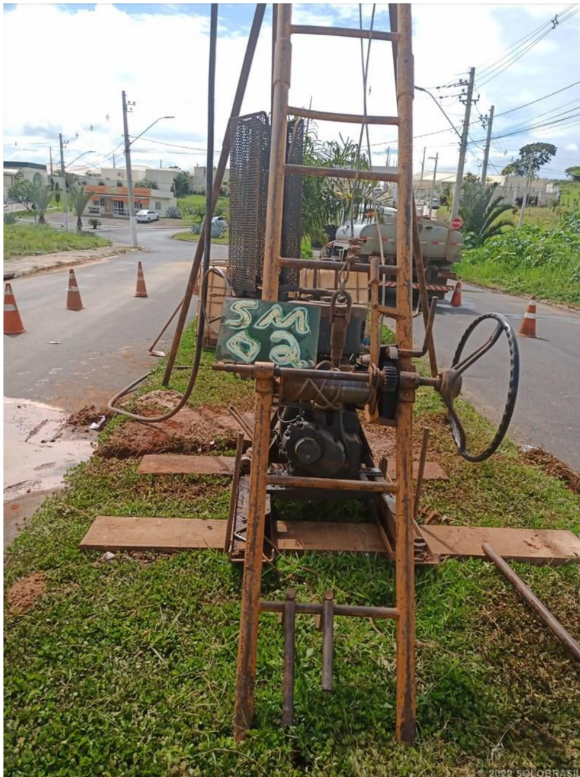
Montagem do equipamento - SM02
