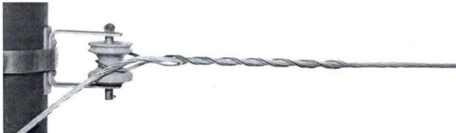
A Alça Preformada de Serviço - SG destina-se à ancoragem dos cabos ou fios de alumínio nus ou revestidos em entradas de consumidor ou ainda à fixação do neutro do cabo multiplexado usado em ramais de serviço.
