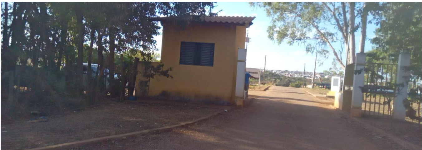
Figura 4 - Foto do local da Estação de Tratamento de Esgoto (ETE) - estaca 59+0,000
