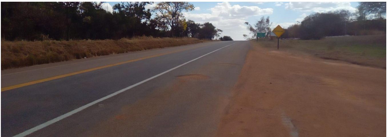
Figura 6 - Foto do local onde será a interseção 2 - estaca 290+13,976
