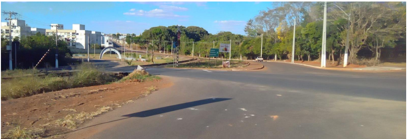
Figura 3 - Foto do local onde será a interseção 1 - estaca 0+0,000
