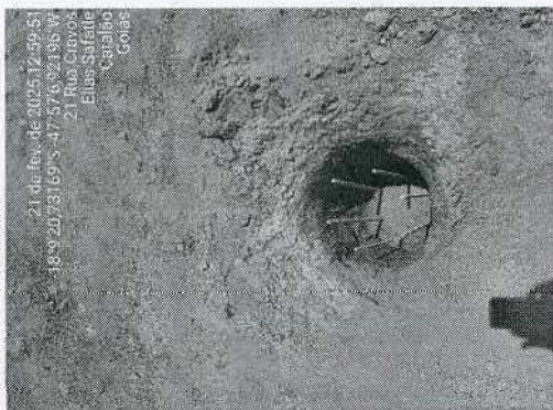
CONCRETAGEM ESTACAS
