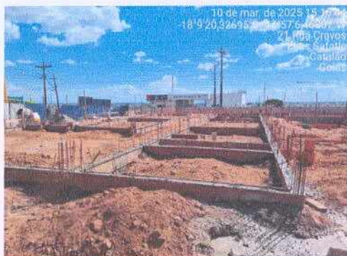
VIGAS CONCRETADAS
