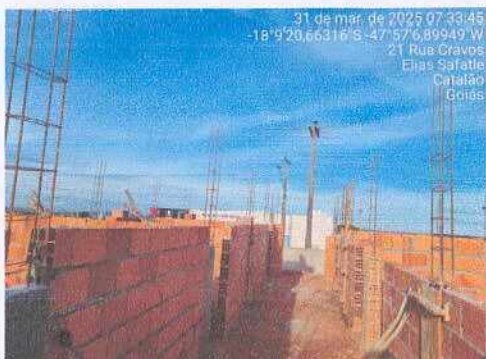
ALVENARIA E PILARES
