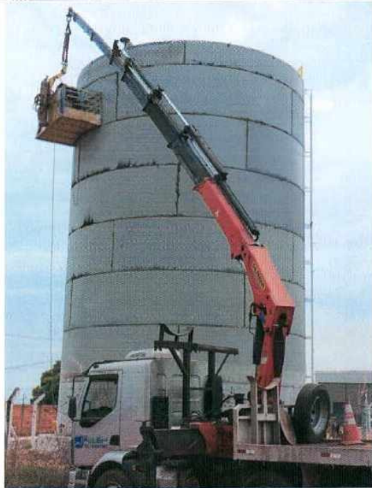
Montagem do Teto
