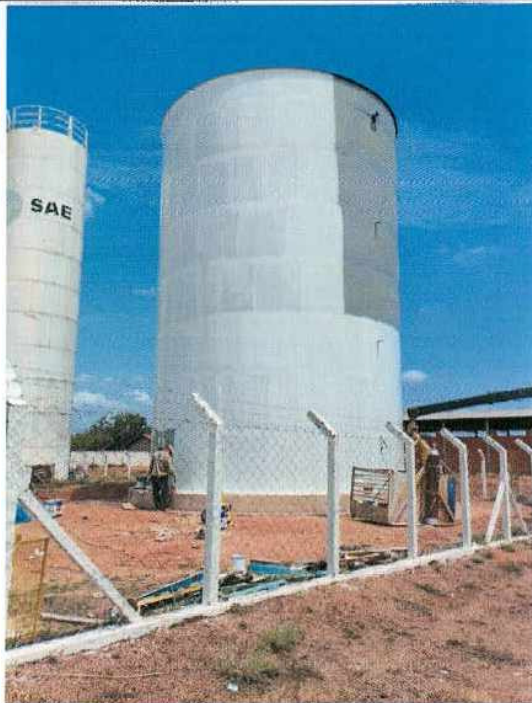
PINTURA DO RESERVATÓRIO
