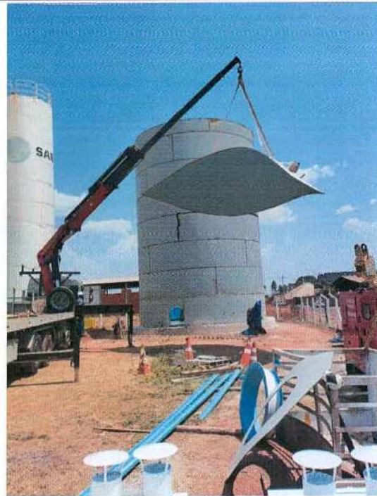
Montagem do Teto
