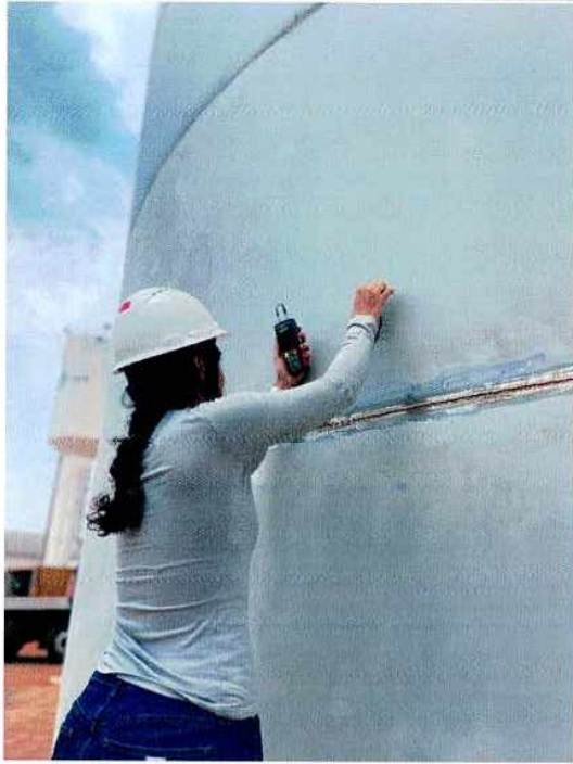
Medição de espessura
