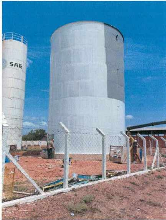
PINTURA DO RESERVATÓRIO
