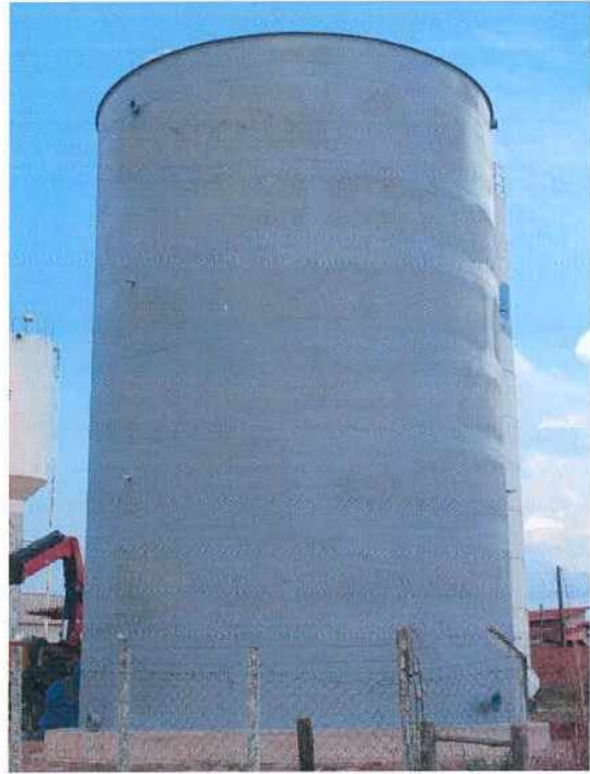
PINTURA DO RESERVATÓRIO
